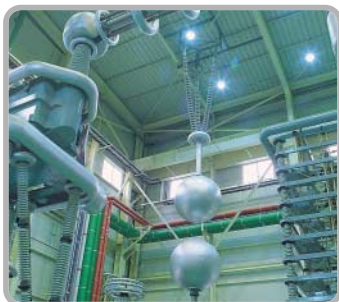
Испытание импульсом в лаборатории высоких напряжений
